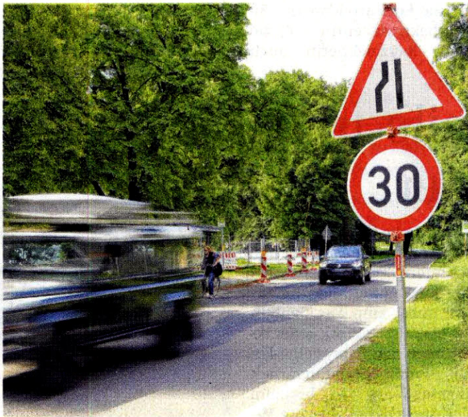
Tempo 30 ist am Westufer des Tiefwareensees geboten. Auf Höhe der Haltestelle Amsee entsteht ein Steg.
